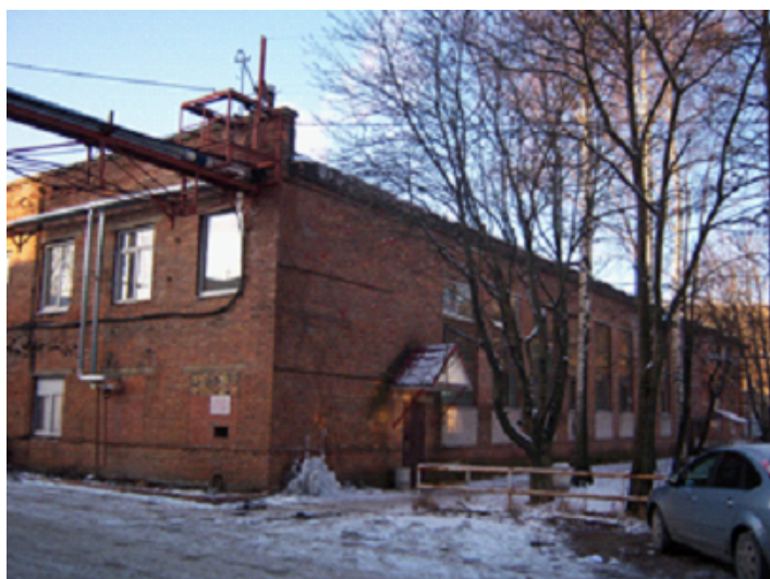
Общий вид здания Бизнес-инкубатора
